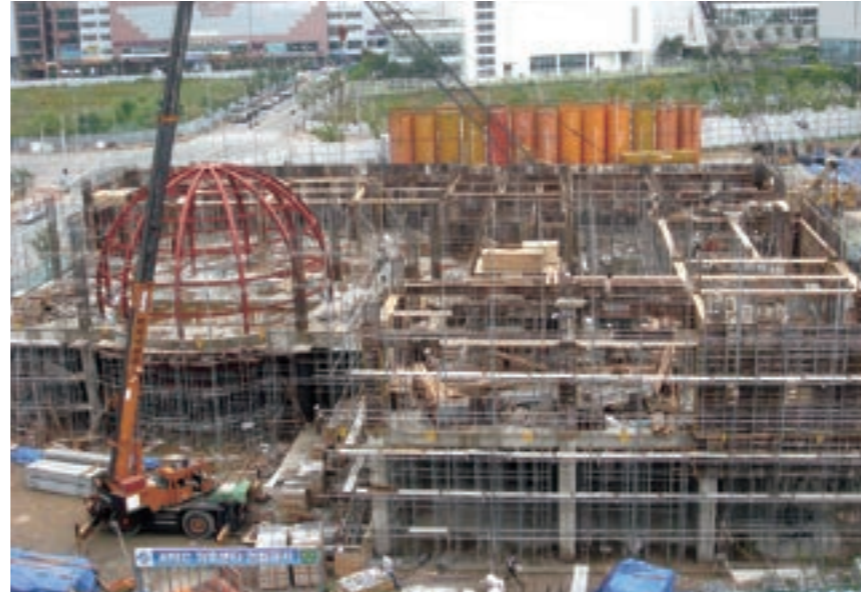
청사 공사 현장(2007년)
