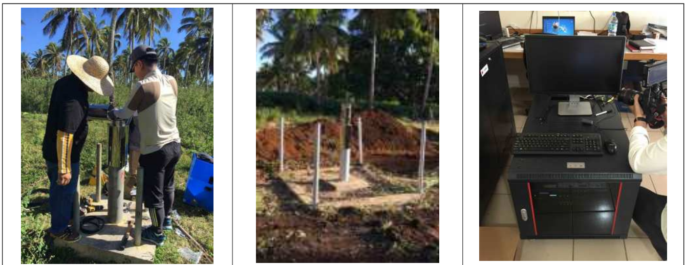
그림 2. SMB지점 지하수 자동관측 Data Logger설치 및 서버시스템 구축
