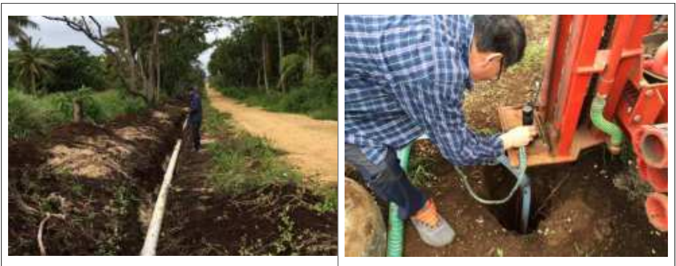
그림 3. 토양 및 식생 구조 파악, Drilling 지역의 지층구조 세부조사 장면
